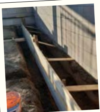
Neue Urnengräber entlang der Urnenwand
